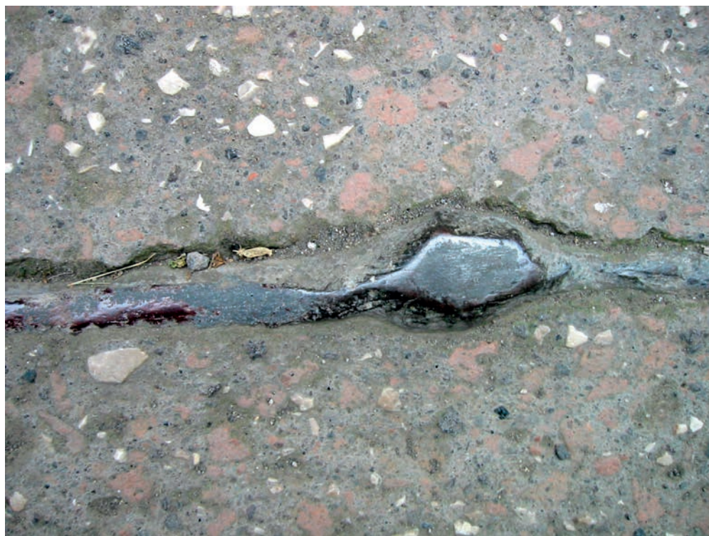
Hauswasserleitung aus Blei
